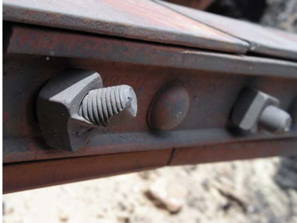
Photo 3. Marque d'impact sur le boulon de l'éclisse du contre-rail
