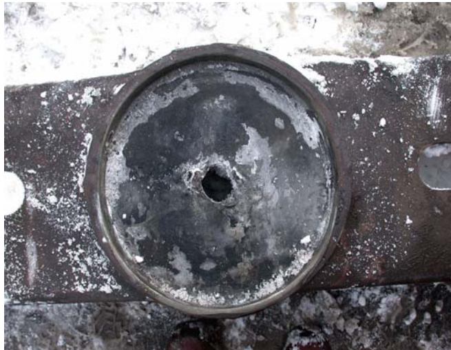
Photo 1. Trou de la cheville ouvrière de la traverse pivot
