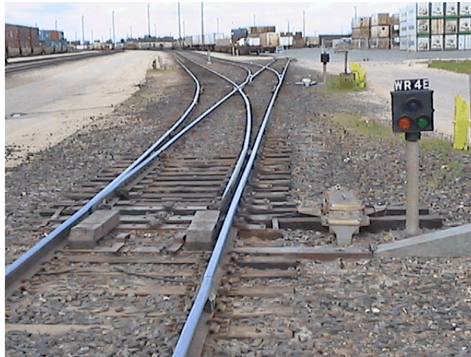
Photo 1. Voies de classement vues en direction ouest à la hauteur de l'aiguillage WR4E du triage Symington (photo du BST). Aiguillage orienté pour permettre l'entrée du mouvement sur la voie WI03.
