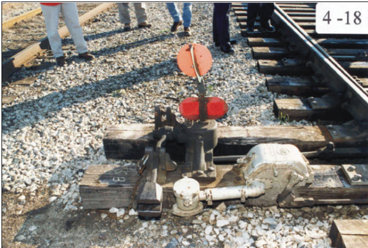
Figure 3 - Aiguillage de liaison ouest au point milliaire 46,72 orienté et cadenassé en position renversée
