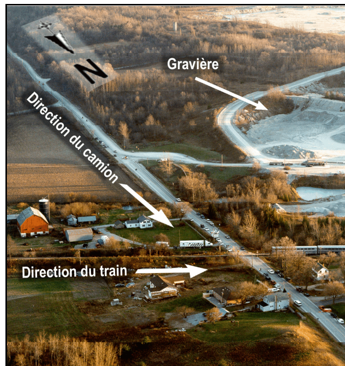
Figure 5 - Vue aérienne du passage à niveau en direction sud
