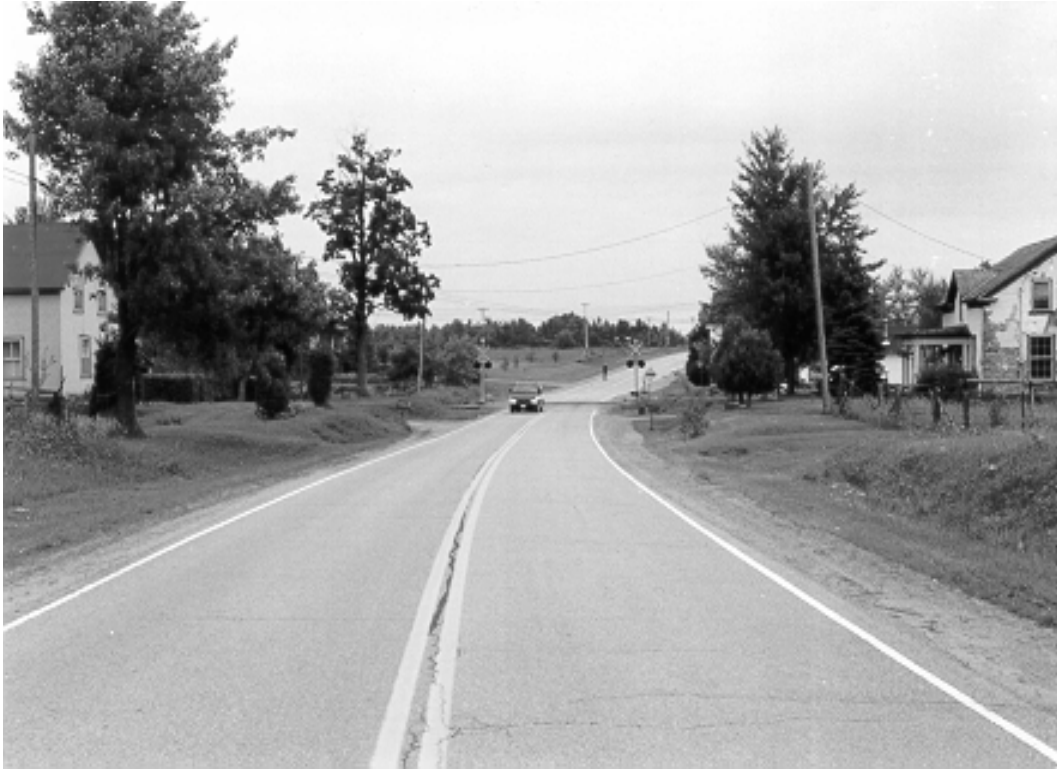
Figure 1 - Passage à niveau du point milliaire 18,13 de la subdivision Brockville du CFCP, vu de l'ouest
