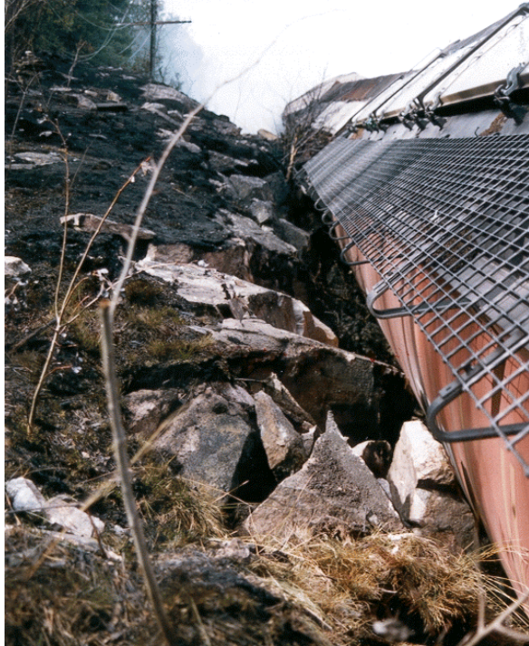
Figure 8 — Côté d'un wagon déraillé reposant contre un talus rocheux à l'intérieur de la courbe (côté sud de la voie principale)
