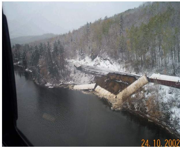
Photo 1. Vue des wagons déraillés
