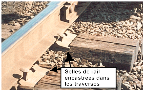
Photos 1 et 2. État de la voie près du point de déraillement initial, y compris selles de rail encastrées et crampons lâches.
