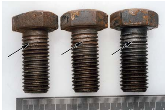
Photo 4. Usure par frottement sur les filets des vis de blocage
