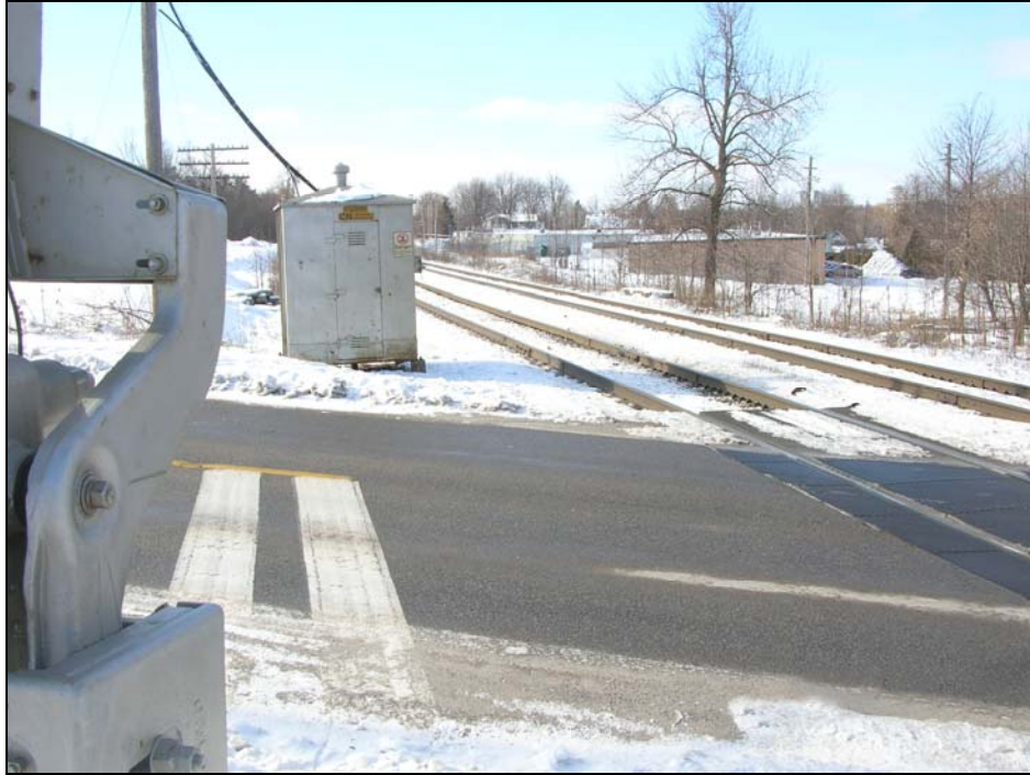
Photo 1. Vue vers l'ouest à partir du trottoir situé dans le quadrant sud-est du passage à niveau de la rue Bartholomew
