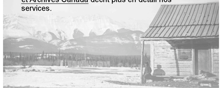
Dans la vallée Jasper House, direction ouest, 15 janvier 1872 (PA-009149)
