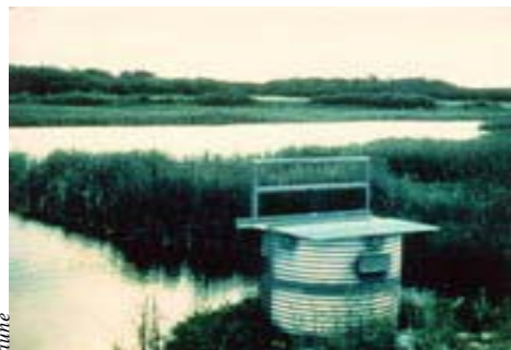
Le contrôle des niveaux d'eau peut profiter aux terres humides.
