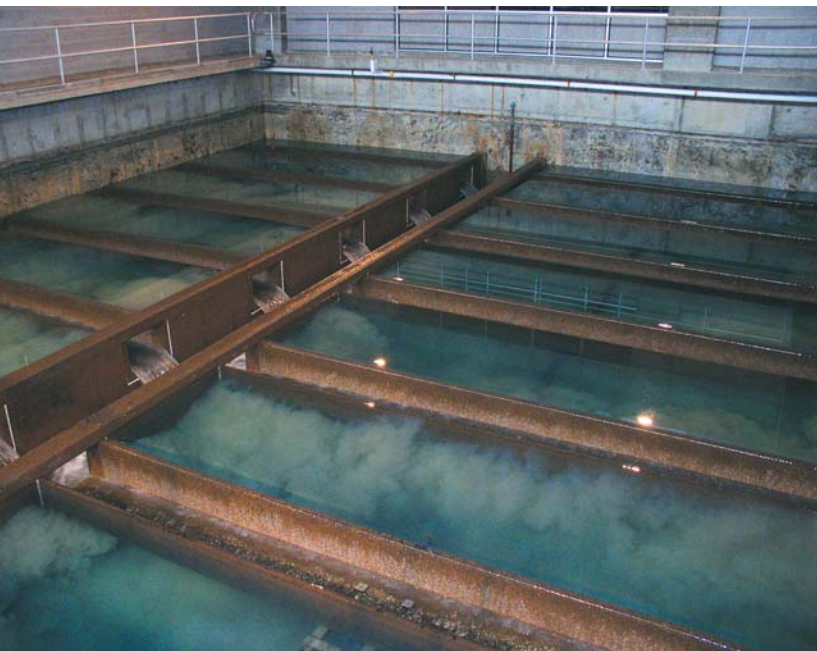
Lavage à contre-courant de filtres à sable dans une station d'épuration d'eaux usées
