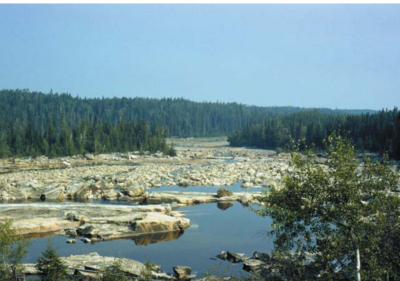
Les rapides Ogoki abandonnés. Vue vers le nord-est (baie James) à partir du barrage Waboose. Toutes les eaux de l'ancien cours d'eau sont dérivées vers le sud dans les lacs Nipigon et Supérieur la plupart du temps.
