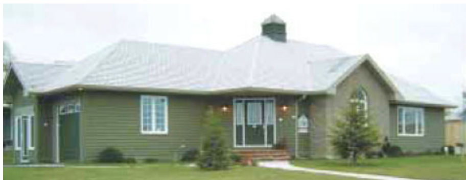
L'installation de Bracebridge
