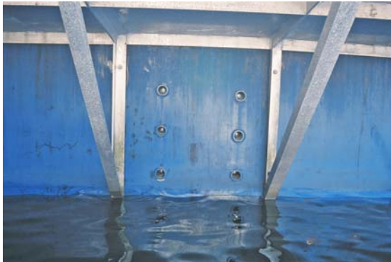
Photo 2. Vue extérieure du tableau arrière sous la plate-forme montrant les six orifices de refoulement d'eau de mer reliés aux viviers.
