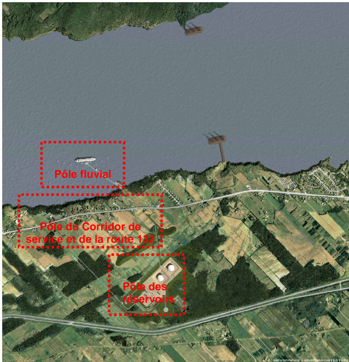
Figure 8 : Les infrastructures du terminal méthanier Rabaska
