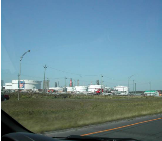
Les réservoirs de la raffinerie Ultramar, à Saint-Romuald, le long de l'autoroute 20.
