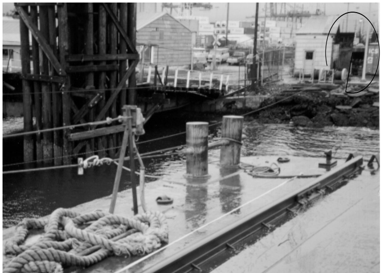
Figure 5 - Hanche tribord du chaland. Le treuil d'amarrage et le lampadaire du quai sont encerclés.
