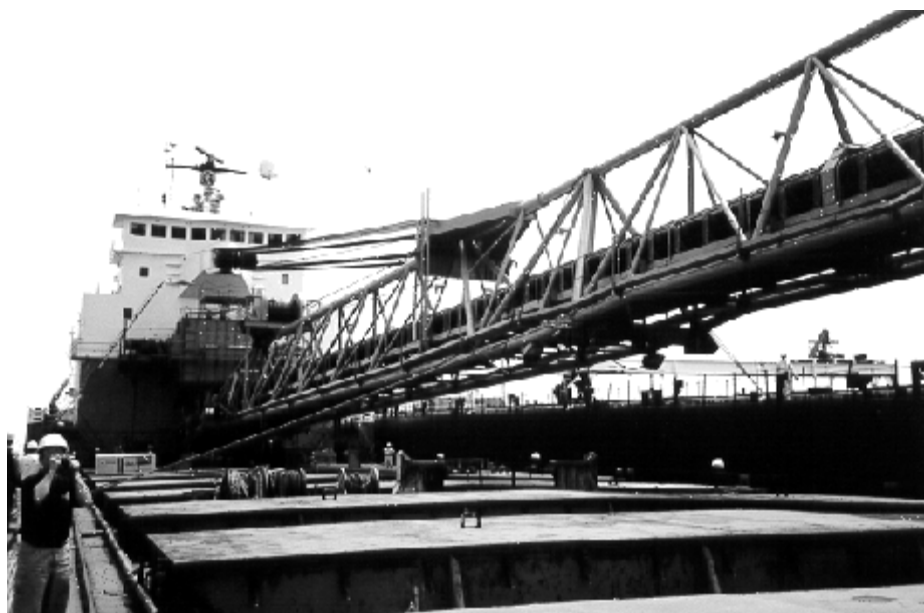
Mât de déchargement en position relevée
