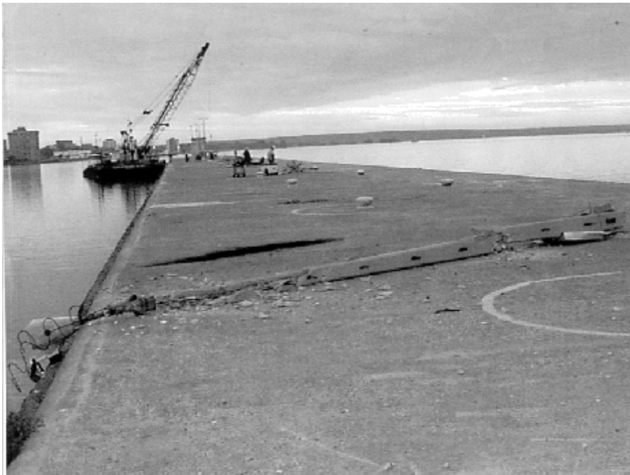
Lampadaires renversés sur le quai
