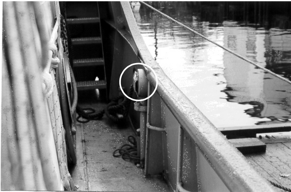
Évent (encerclé sur la photo) de la soute à carburant de tribord qui a été immergé. Cet évent n'a pas réussi à empêcher l'eau de mer de pénétrer dans la soute.
