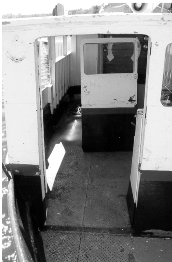
Photo 11. Ouverture dans l'avant de la superstructure avec la porte enfoncée et poussée de force à l'intérieur de la superstructure, et empreinte corrodée du seuil de porte manquant sur le pont principal.
