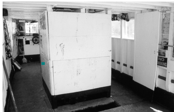
Photo 5. Capotage du moteur avec les panneaux de contreplaqué amovibles en place, montrant l'ouverture à l'arrière pour la ventilation du moteur.
