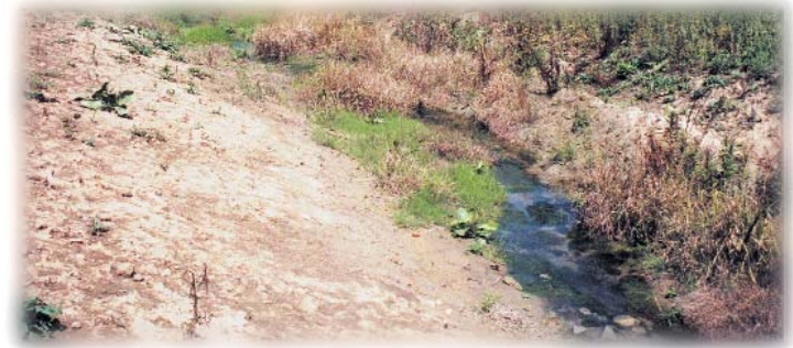
Qu'il s'agisse d'un drain privé, comme celui ci-dessus, ou d'un drain municipal, sous entente mutuelle ou sous adjudication, tous se ressemblent et on peut facilement les confondre.
