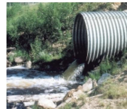
Des ouvrages de drainage mal installés font obstacle au passage des poissons.
