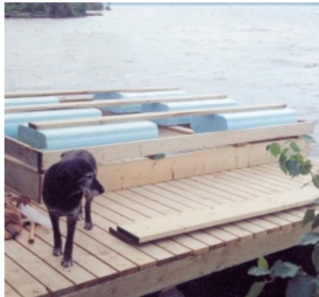
Un quai en construction fait de bois non traité et de polystyrène pour la flottaison.
