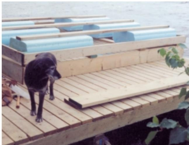
Un quai en construction fait de bois non traité et de polystyrène pour la flottaison.
