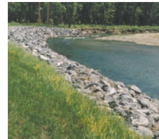
Stabilisation des rives à l'aide de moellons de roches.
