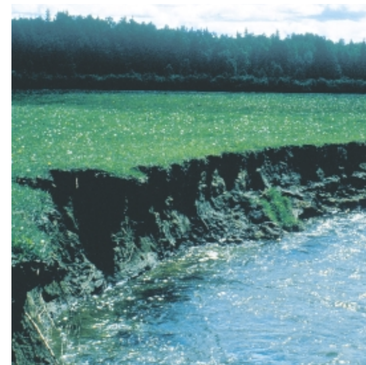
L'enlèvement de la végétation des rivages risque d'entraîner une grave érosion des berges.
