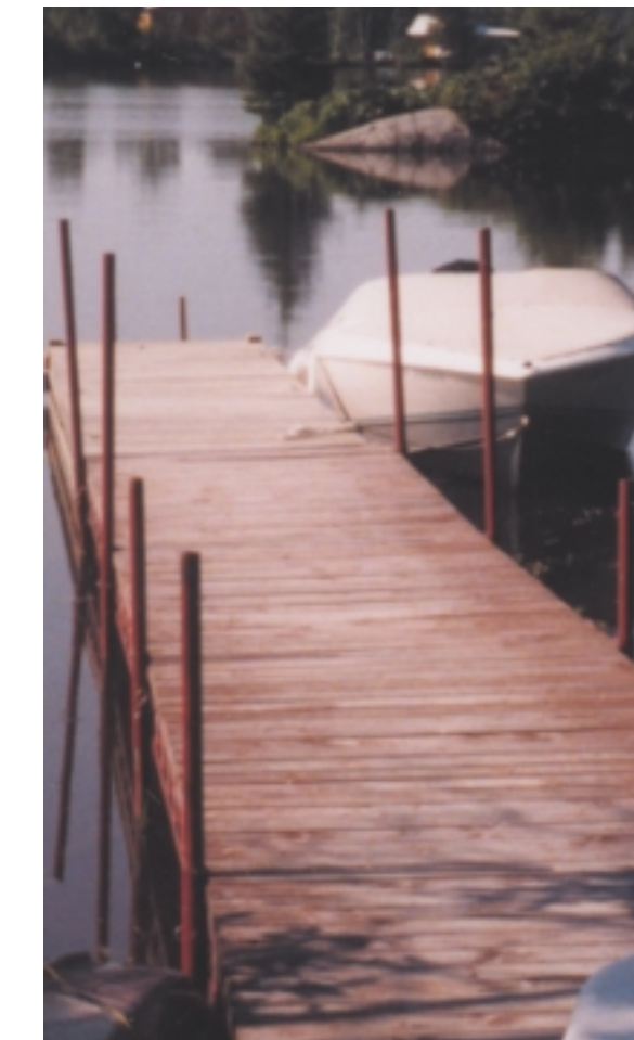
Les quais soutenus par des poteaux causent un minimum de perturbation dans le fond des lacs et des rivières.
