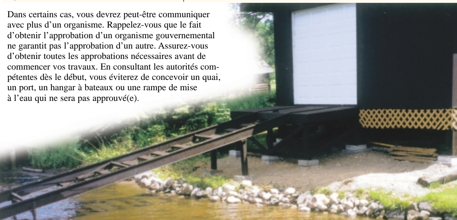
Un hangar à bateaux construit au-dessus de la laisse de crue ne perturbe pas l'habitat du poisson.
