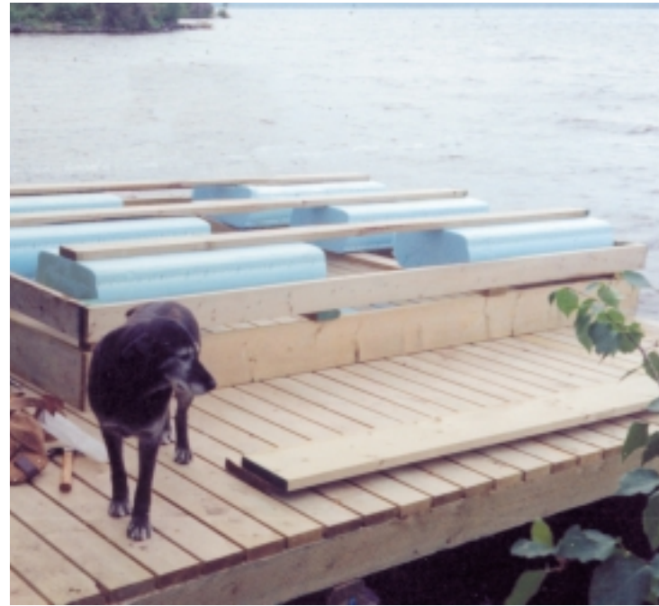
Un quai en construction fait de bois non traité et de polystyrène pour la flottaison.
