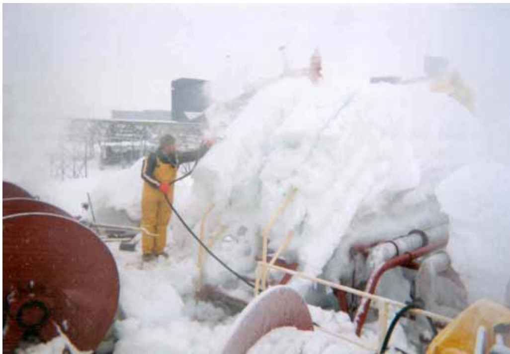
Figures 5.3J – Obstruction de l'accès du pont-château vers le passavant
