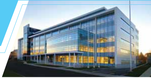
L'édifice dispose d'un « toit vert ».
