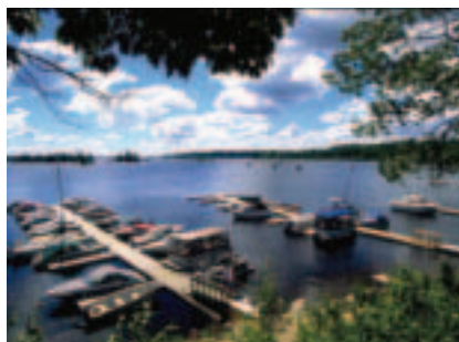
Voie navigable de la rivière des Outaouais
