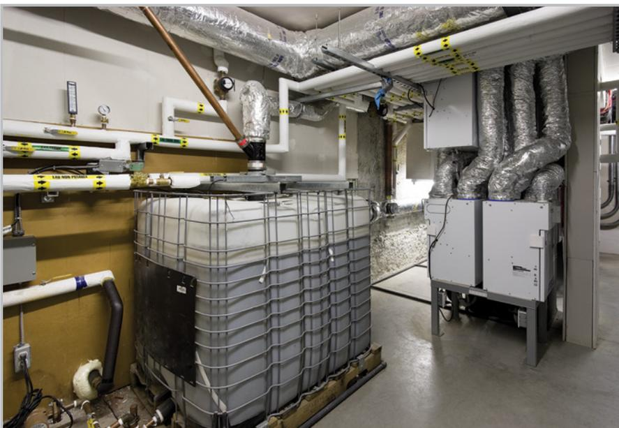
**Figure 8** Réservoir d'eau de pluie de 1 000 L installé à l'intérieur d'un immeuble et devant servir à alimenter la chasse des toilettes de trois appartements en copropriété. Le réservoir est doté d'un système de mise à niveau garantissant la disponibilité de l'eau en permanence.
