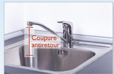
**Figure 18** Coupure antiretour empêchant les eaux usées de s'immiscer dans la source d'eau potable du robinet et de la contaminer.
