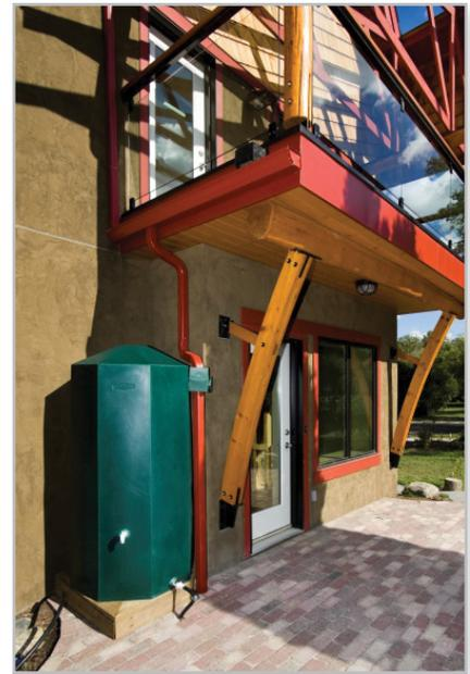
**Figure 2** La collecte de l'eau de pluie dans sa forme la plus simple : un baril placé sous une descente pluviale
