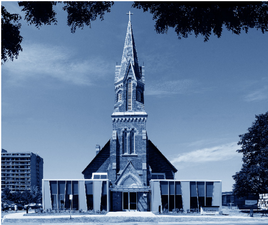
L'ancienne église catholique St. Francis à Ajax a été transformée en un espace multiculturel et théâtral, le centre St. Francis. Il s'agit d'un exemple de la possibilité d'adapter un lieu du culte patrimonial pour de nouvelles utilisations afin de répondre aux besoins de la collectivité. (Photographie généreusement fournie par Paul Mitchell)
