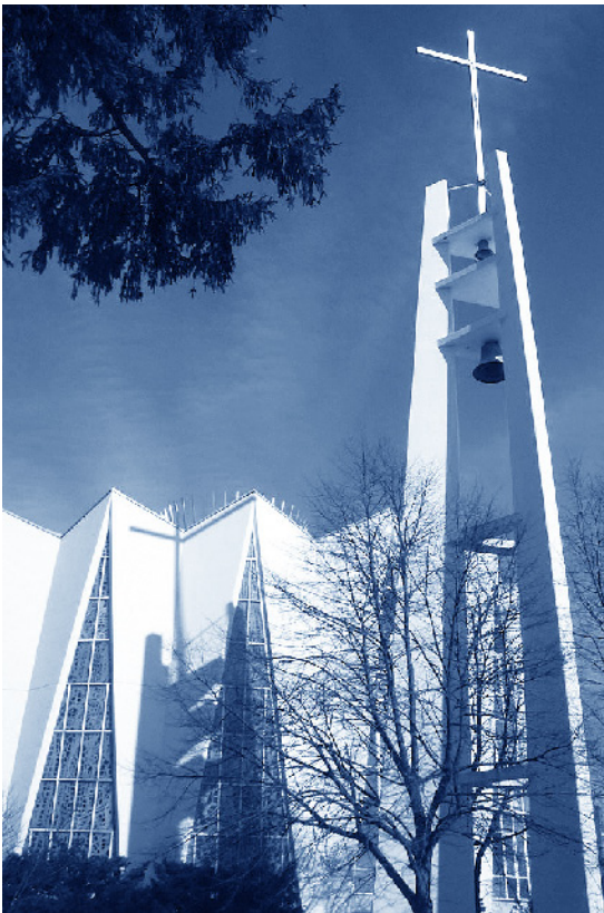
La chapelle Pines de Chatham-Kent est un exemple éloquent d'architecture moderne. Ses vitraux en forme de triangle sont encastrés dans des murs de bétons blancs qui s'élèvent en s'amincissant pour former les pointes d'une couronne. La chapelle a été évaluée par la municipalité et est désignée aux termes de la Loi sur le patrimoine de l'Ontario pour sa conception et son importance contextuelle. (Photographie généreusement fournie par la municipalité de Chatham-Kent)
